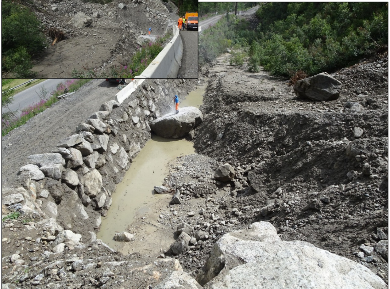
Abb.13. Sprengung der Blöcke im Lawinenauffangbecken
