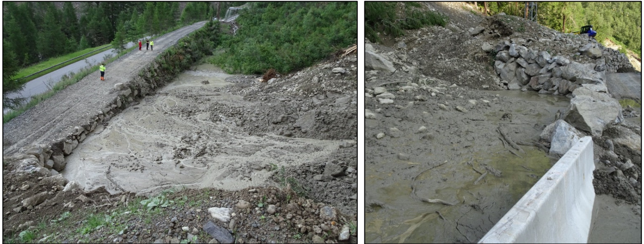
Abb.11. (links) Verfülltes Lawinenauffangbecken zwischen Leckgalerie und Klammgalerie; (rechts) übervolles Lawinenauffangbecken mit provisorischer Erhöhung;
