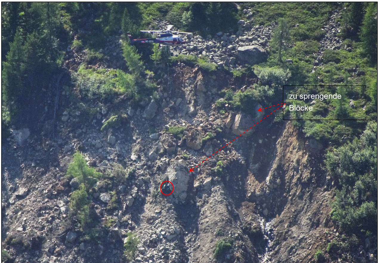
Abb.16. Sprengarbeiten im mittleren Hauptbewegungsbereich, rot Sprengmeister am Seil
