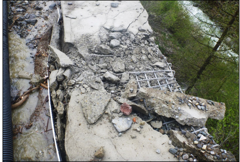
Abb.8. Blocksturz auf die Leckgalerie, der ca. 30m 2 Block ist orographisch rechts am Ufer eingeschlagen
