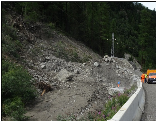
Abb.11. (links) Verfülltes Lawinenauffangbecken zwischen Leckgalerie und Klammgalerie; (rechts) übervolles Lawinenauffangbecken mit provisorischer Erhöhung;
